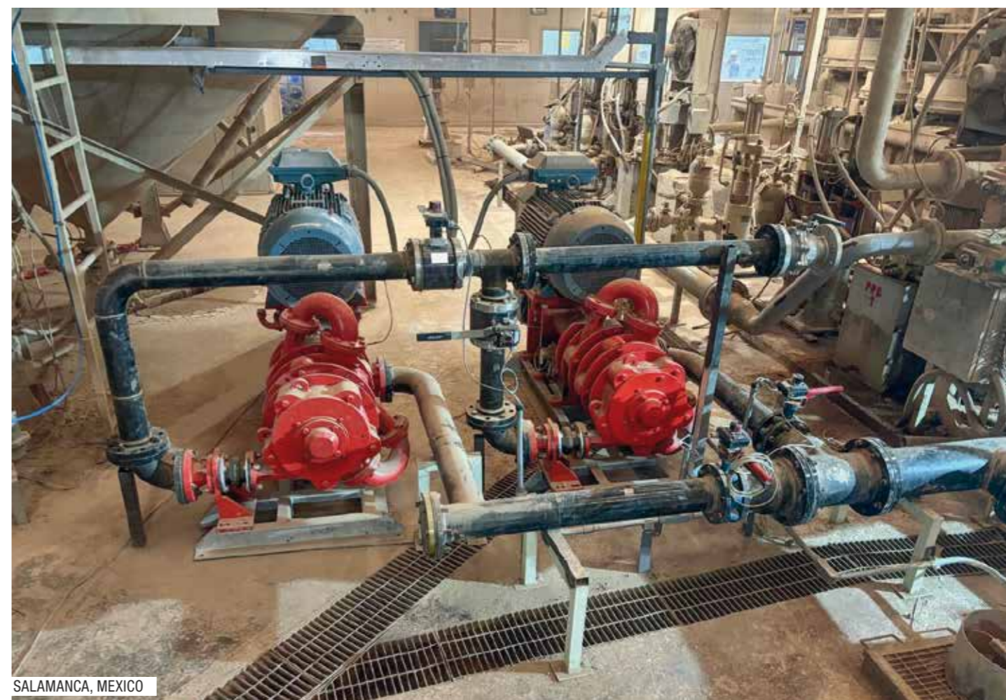
N°2 3PowerFlow pumps 650 - 90 kW
