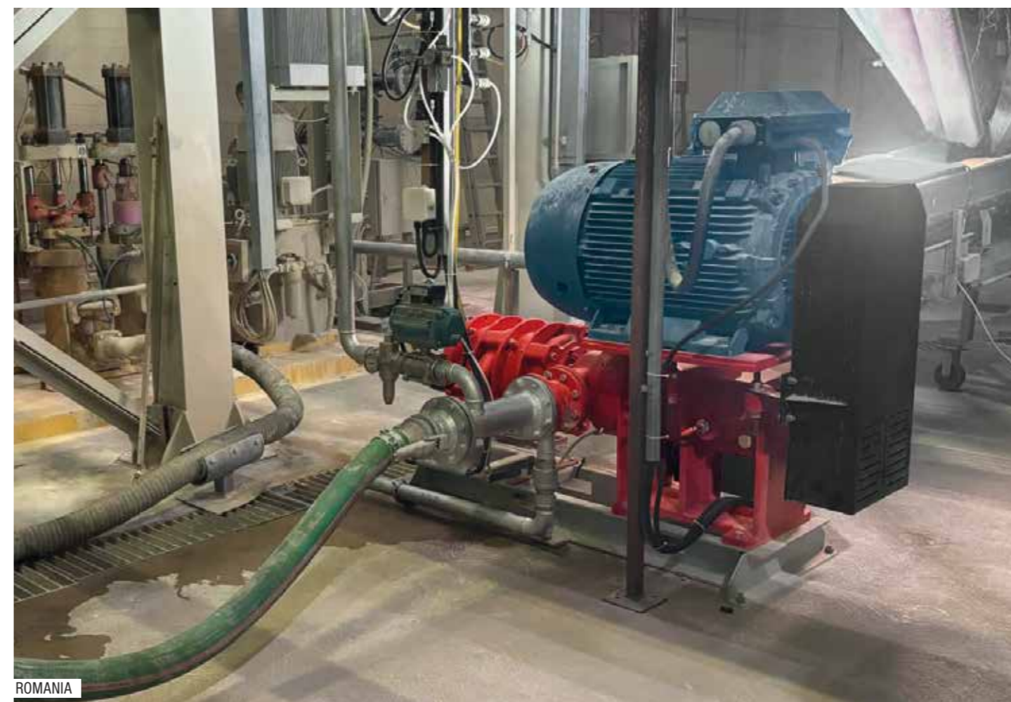
N°1 3PowerFlow pump 550 - 75 kw
