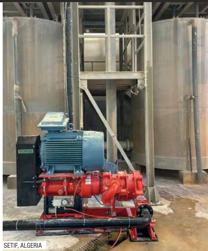
N°1 3PowerFlow pump 550 - 90 kW
