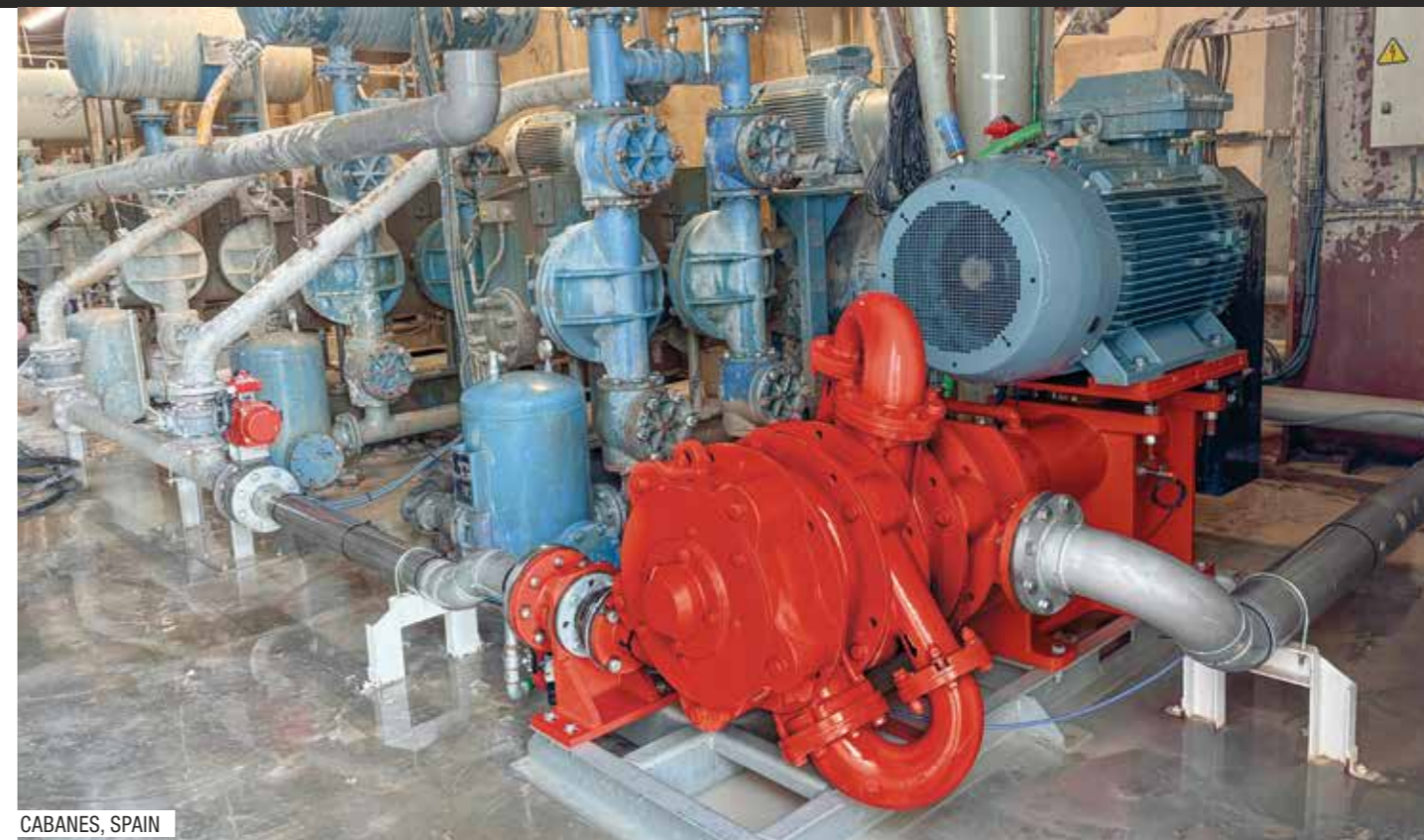
N°1 3PowerFlow pump 650 - 90 kW
