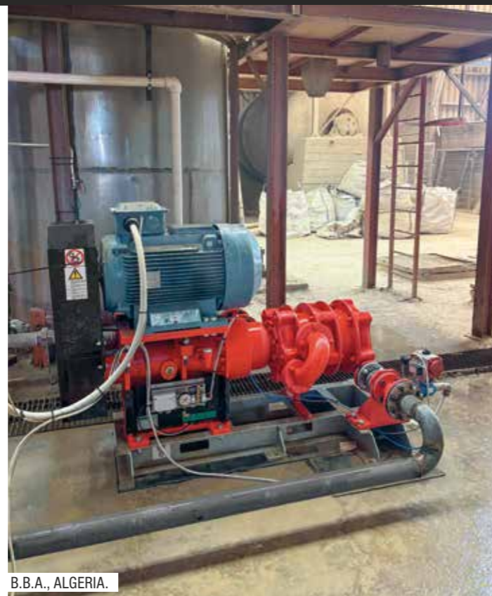
N°1 3PowerFlow pump 550 - 55 kW
