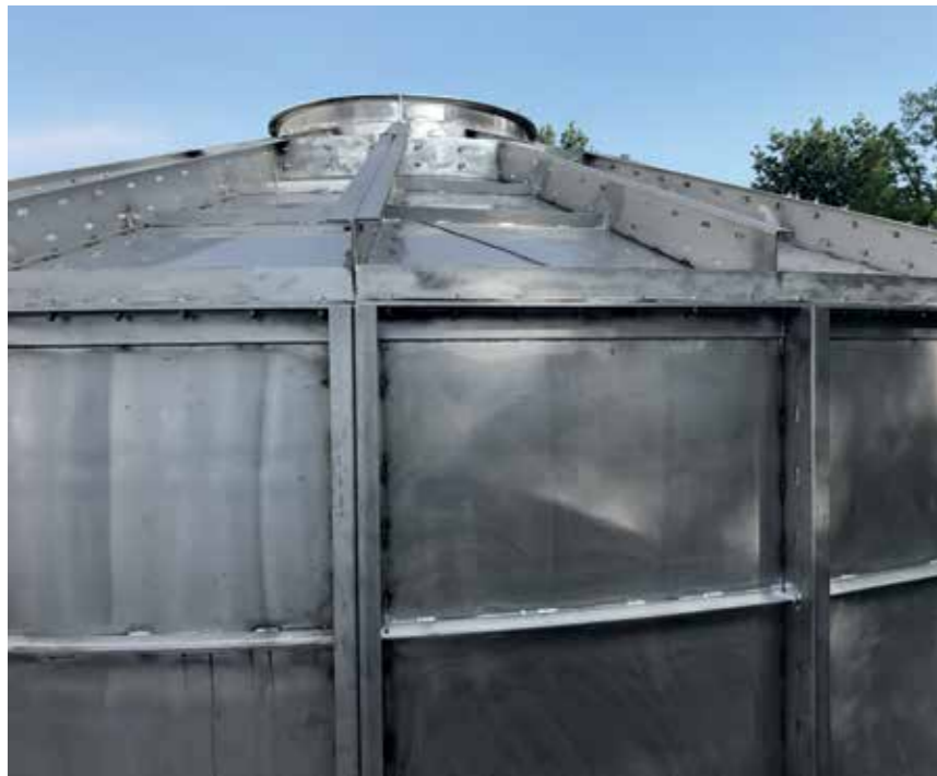
Dettaglio struttura autoportante di cappello e cilindro. Detail of self-supporting structure of cap and cylinder. Detalle estructura autoportante de sombrero y cilindro. Détail structure autoportante de chapeau et cylindre. Detalhe estrutura autoportante de chapéu e cilindro.
