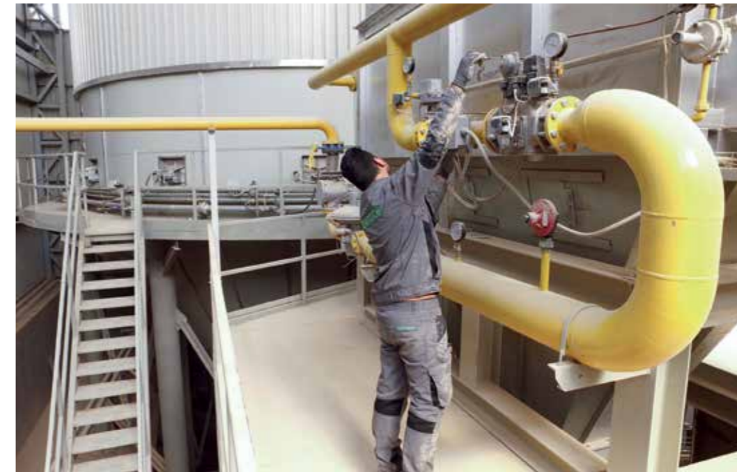
Dettaglio rampa gas bruciatore. Detail of burner gas ramp. Detalle rampa gas quemador. Détail rampe gaz brûleur. Detalhe da rampa do gás queimador.
