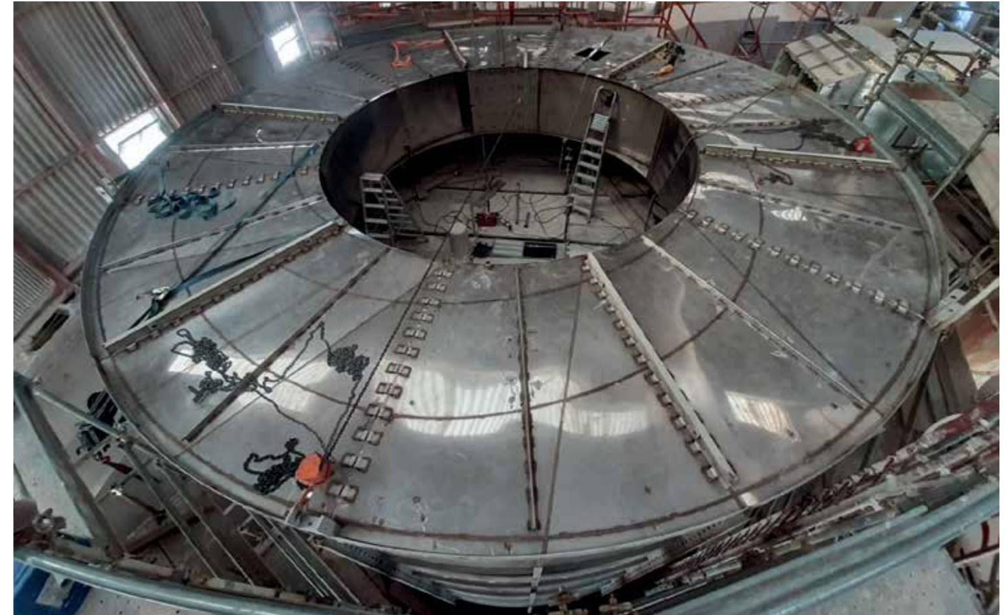
Diffusore con entrata aria tangenziale in fase di montaggio. Diffuser with tangential air inlet during installation phase. Difusor con entrada aire tangencial en fase de montaje. Diffuseur avec entrée air tangentielle en phase d'installation. Difusor com entrada ar tangencial em fase de instalação.
