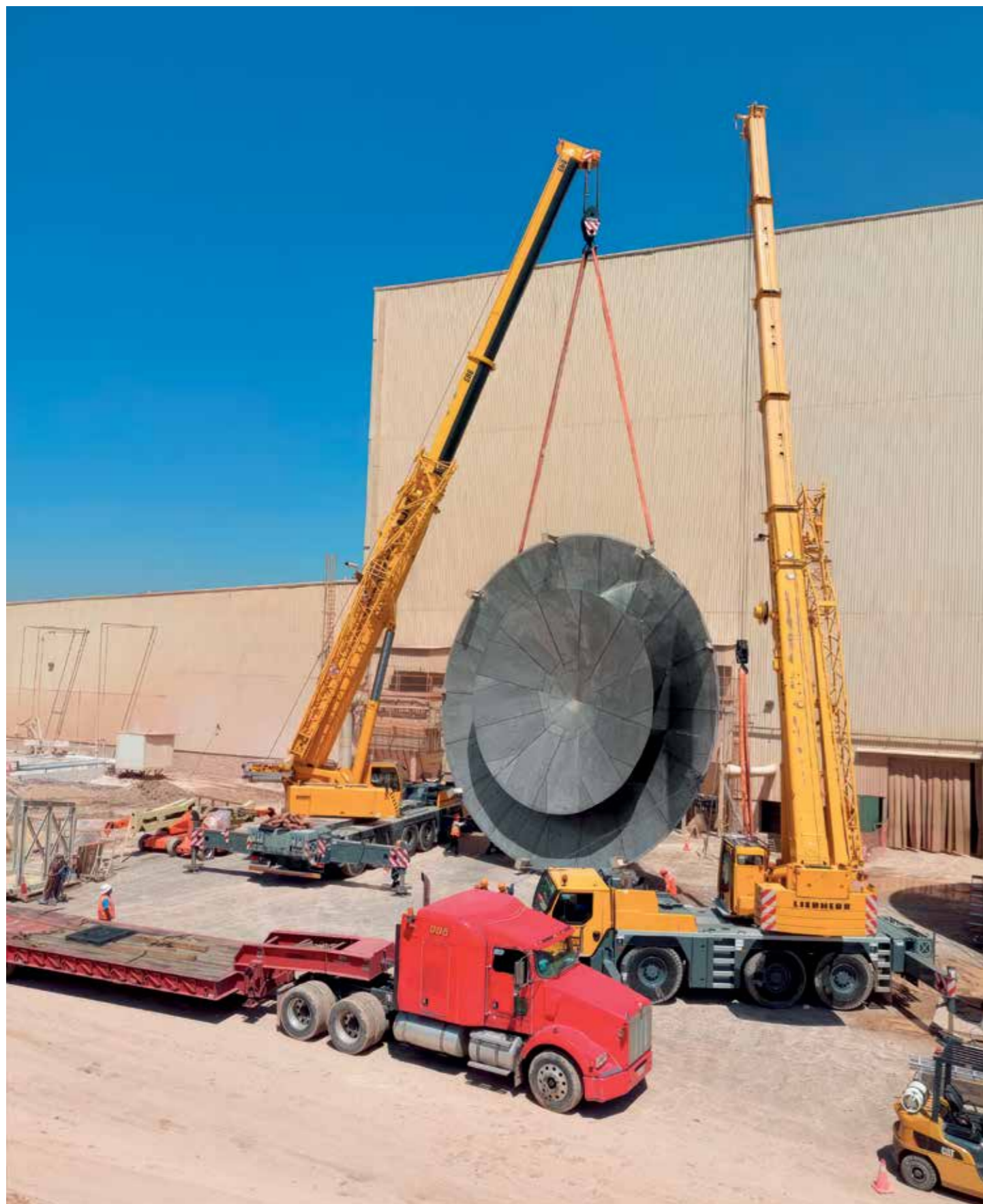
Cappello completo di diffusore per atomizzatore con capacità evaporativa di 22.000 Lt/h. Cap complete with diffusor for spray-drier with evaporative capacity of 22.000 Lts/h. Sombrero completo de difusor para atomizador con capacidad evaporativa de 22.000 Lts/h. Chapeau complète de diffuseur pour atomiseur avec capacité évaporative de 22.000 Lts/h. Chapéu completa com difusor para atomizador com capacidade de evaporação de 22.000 Lts/h.
