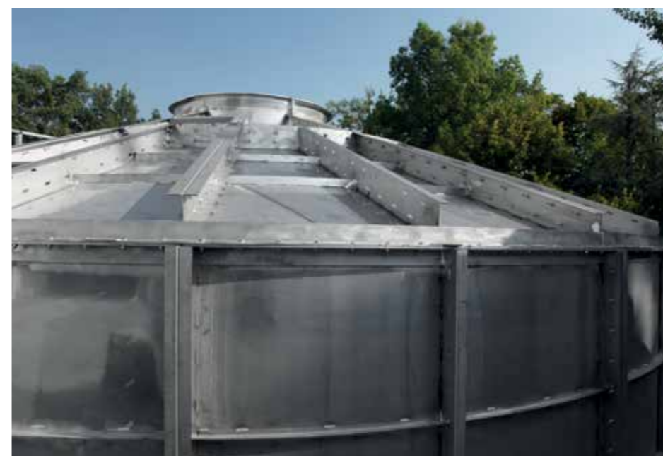
Porzione di cilindro e cappello autoportanti costruiti interamente in acciaio inox. Self-supporting cylinder and cap portion completely built in stainless steel. Sección de cilindro y sombrero autoportantes construidos enteramente en acero inoxidable. Section de cylindre et chapeau autoportants construits entièrement en acier inoxydable. Parte do cilindro e chapéu autoportantes fabricados totalmente em aço inox.
