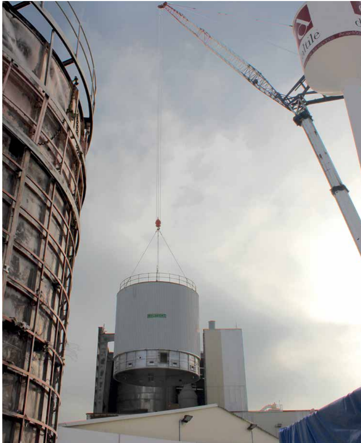
Sostituzione cilindro e cappello con entrata aria calda tangenziale, con uno nuovo di maggiori dimensioni con entrata aria calda centrale. Replacement of cylinder and cap with tangential hot air entry, with a new one with bigger dimensions with central hot air entry. Sustitución cilindro y sombrero con entrada aire caliente tangencial, con uno nuevo de dimensiones mayores con entrada aire caliente central. Remplacement cylindre et chapeau avec entrée air chaud tangentiel, par un nouveau, de dimensions plus grandes avec entrée air chaud centrale. Substituição do cilindro e chapéu com entrada de ar quente tangencial, com um novo de maiores dimensões com entrada de ar quente central.
