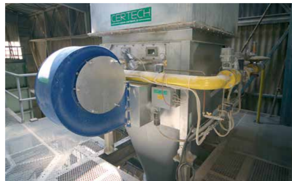
Dettaglio bruciatore in vena d'aria. Detail of the duct burner. Detalle quemador en vena de aire. Détail brûleur en veine d'air. Detalhe do queimador na veia de ar.
