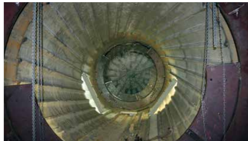
Assemblaggio di n. 2 anelli in acciaio all'interno del mulino. Assembly of the 2 steel ring inside the mill. Ensamblaje de nr. 2 anillos en acero en el interior del molino. Assemblage de nr. 2 anneaux en acier à l'intérieur du broyeur. Montagem de 2 anéis de aço no interior do moinho.
