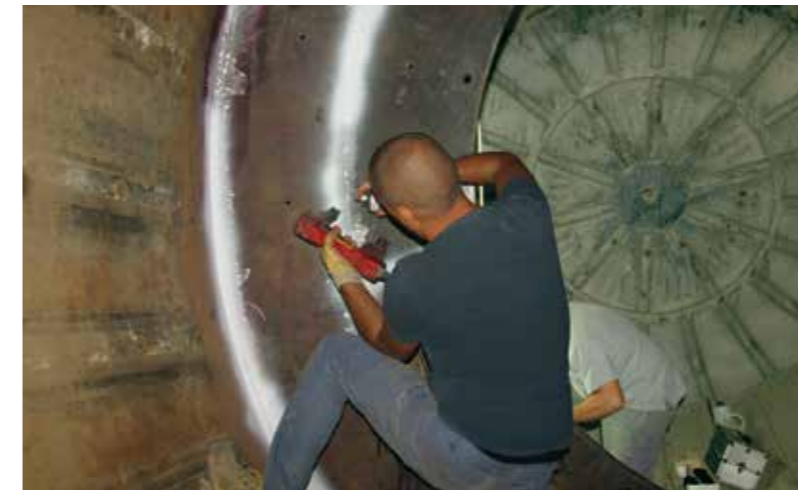
Controllo strutturale della parte interna del mulino con liquidi penetranti ed ultrasuoni. Structural testing of the inner part of the mill with liquid and ultrasound. Control estructural de la parte interna del molino con líquidos penetrantes y ultrasonidos. Contrôle de la structure de la partie interne du broyeur avec des liquides d'imprégnation et des ultrasons. Controle estrutural da parte interna do moinho com líquidos penetrantes e ultrasons.
